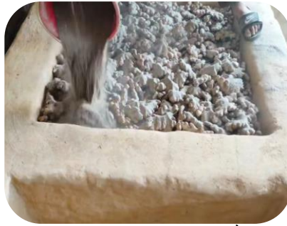
माथिबाट फेरि पनि बालुवा राख्ने (सबै कुना कुना सम्म gap filling हुने गरी)
